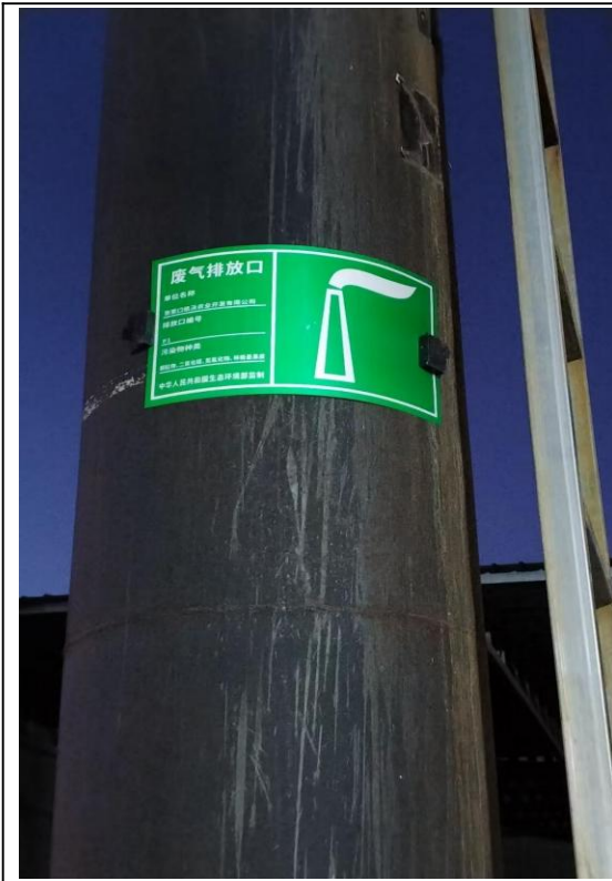
生物质锅炉排气筒 P1
