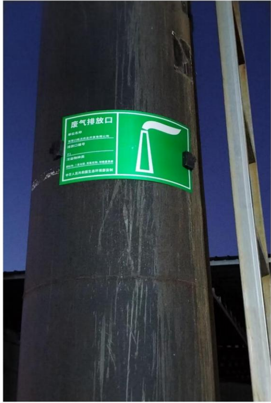
生物质锅炉排气筒 P1
